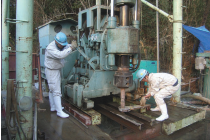
掘削中の現場写真
