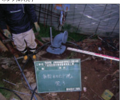
ポンプ挿入完了
