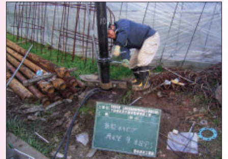
新設ポンプ揚水管9本目完了
