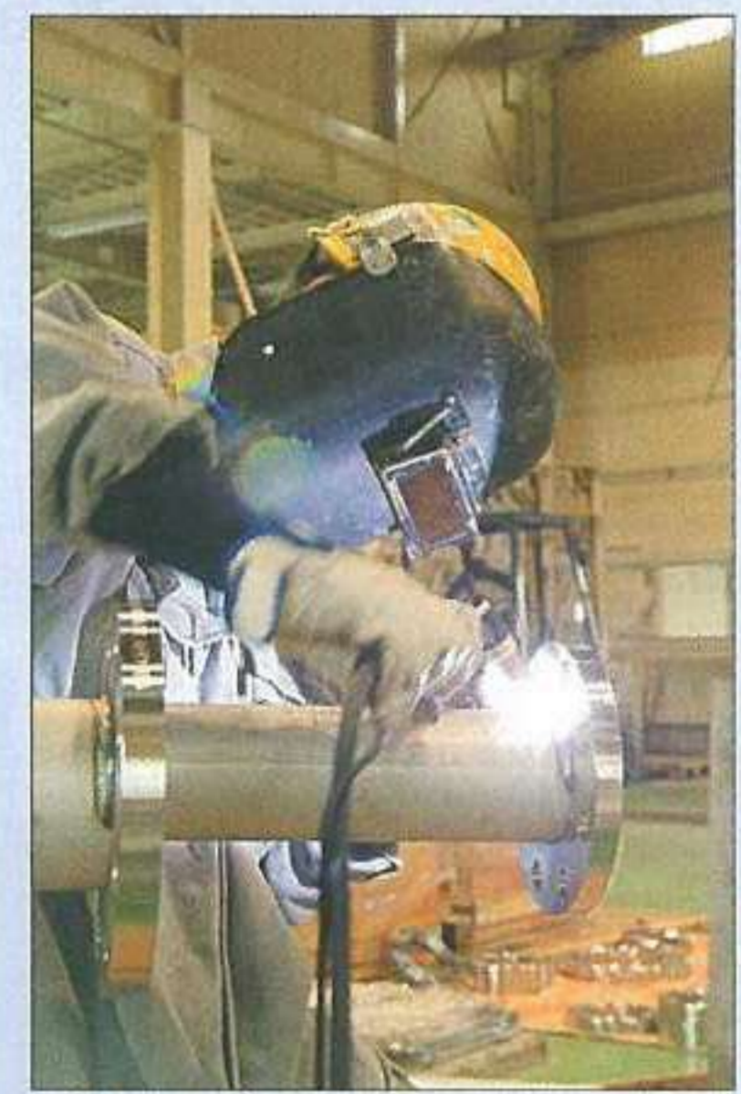
■SUS管溶接中
