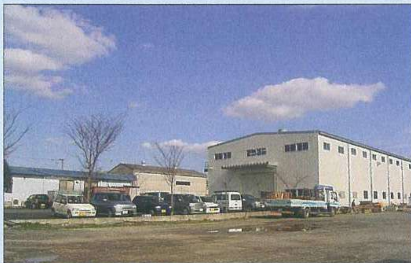
■植木支店・工場全景
